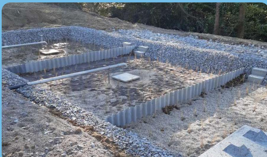
L'ancienne station d'épuration de Puech Guilhem étant en fin de vie, le SIVU des Moulins a entrepris la construction d'une nouvelle station à filtrage par roseaux. Les travaux ont été retardés à cause des intempéries mais elle devrait être opérationnelle d'ici peu.
